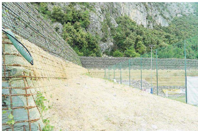
Il vallo paramassi di Sarche protegge scuole e area sportiva dalla caduta di massi dal Dain Picol
