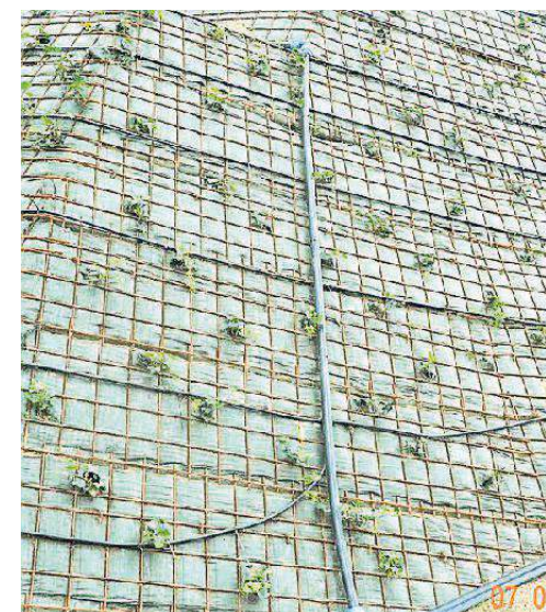
Piante e irrigazione sulle terre armate del vallo
